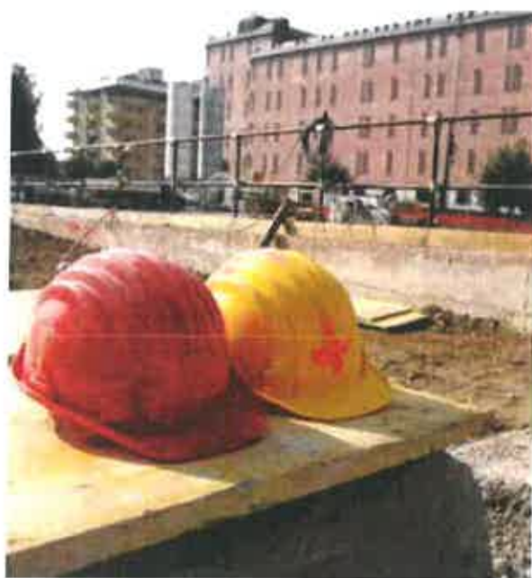
Caschi di protezione in un cantiere edile FOTOLIVE
