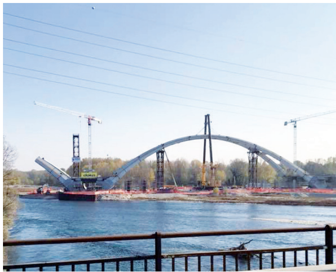
Il nuovo ponte sul Ticino è stato realizzato in funzione del raddoppio del binario ferroviario
