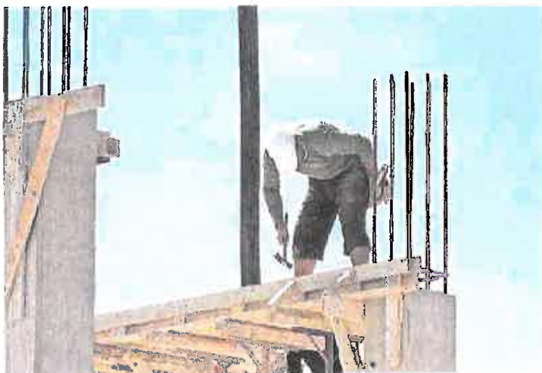
CRISI NEI CANTIERI Un operaio impegnato su un edificio in costruzione
