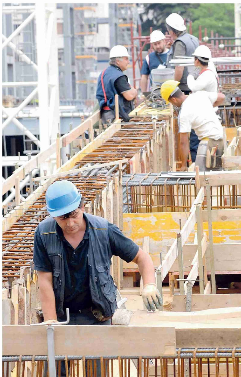
Operai al lavoro in un cantiere edile. Corsa al Superbonus per le ristrutturazioni
