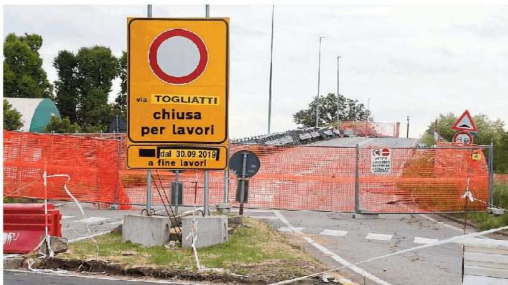
Il cantiere del cavalcavia Togliatti, una strada chiusa dal settembre dello scorso anno e che potrebbe riaprire entro un mese
